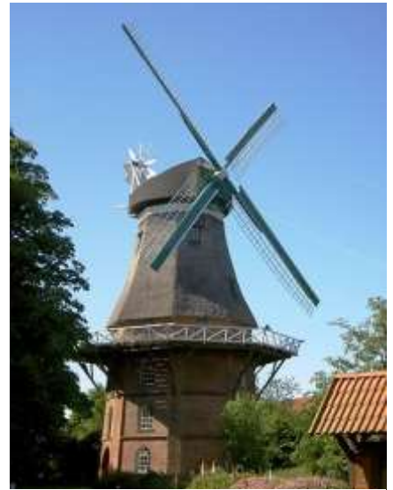
Sanierung der Mühle in Schiffdorf
